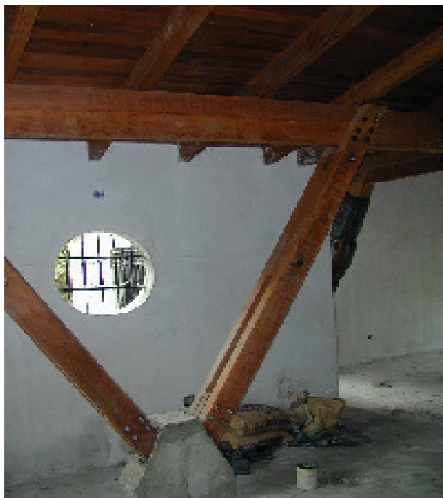
Figura 1. Vista interna de la estructura de madera de Chupón proveniente del estado Barinas, del prototipo Chupón-I, diseñado por Contreras y Owen de C. Foto. Yoston Contreras Miranda, 2000.
