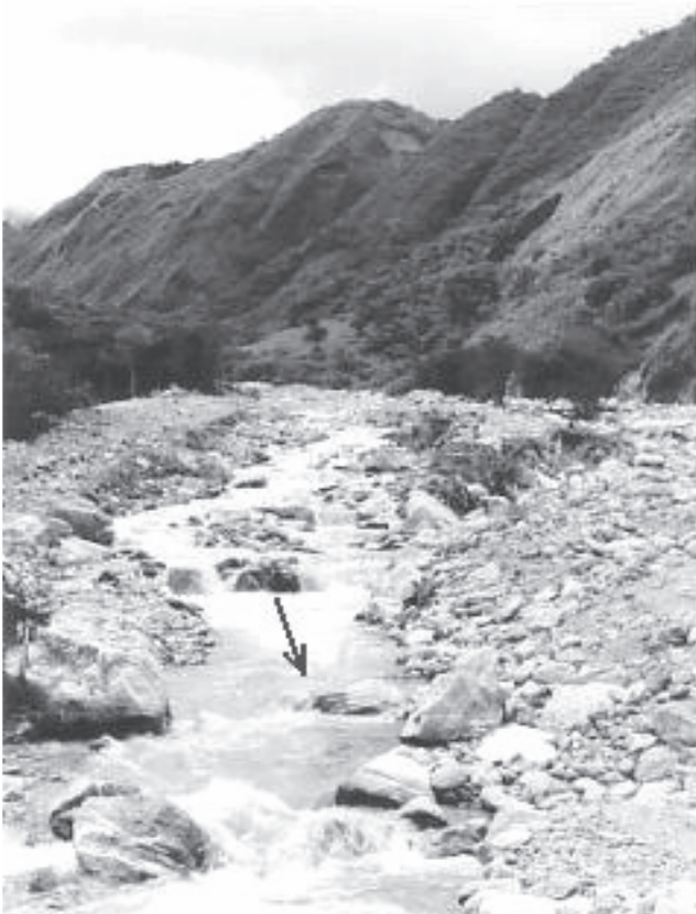
Figura 13. Aguas arriba del Puente Las Piedras, se observa el río con su conformación natural, el efecto del estrechamiento del puente ya no se aprecia.
