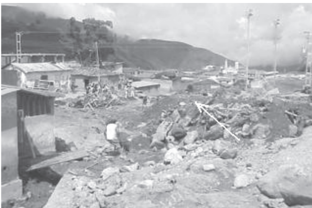
Figura 21. Pueblo Llano, viviendas dañadas en la margen izquierda por la crecida de la quebrada del Pueblo.
