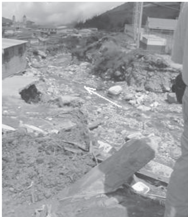
Figura 27. Pueblo Llano, vista de la quebrada hacia aguas abajo, cauce normal.
