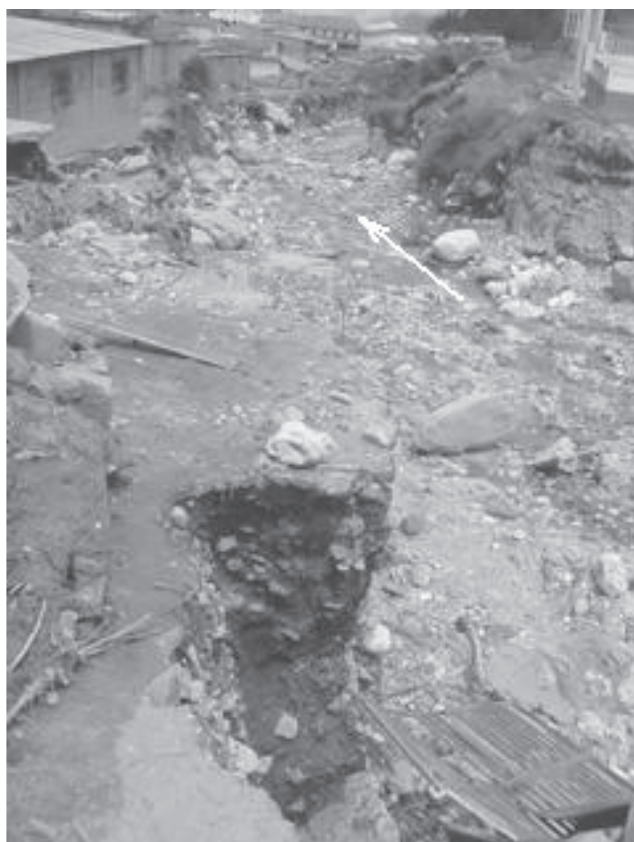
Figura 28. Pueblo Llano, vista de la margen izquierda, daños causados por la quebrada.
