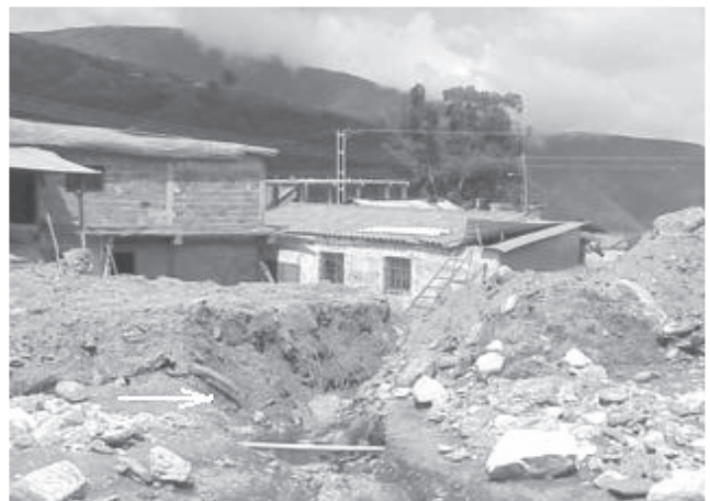
Figura 23. Pueblo Llano, daños causados en la margen izquierda por la crecida de la quebrada del Pueblo.
