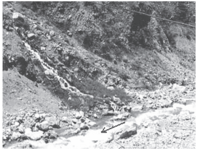
Figura 8. Margen derecha de la quebrada La Sucia, donde no pasó la crecida.
