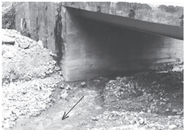
Figura 5. Vista de los estribos, carretera Trasandina, sobre la quebrada La Sucia
