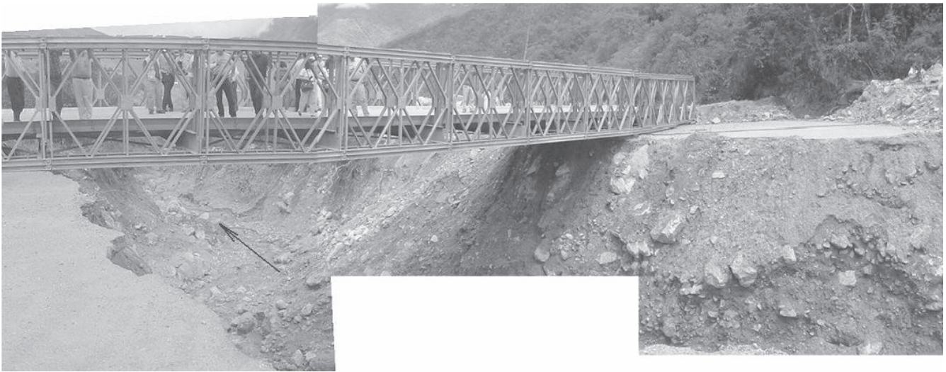
Figura 20. Quebrada Santa Filomena, sobre la carretera hacia Pueblo Llano, erosión causada por la crecida de Junio, puente de guerra colocado a nivel de la carretera para salvar el desnivel, no se observan restos de la estructura que existía antes de la crecida.
