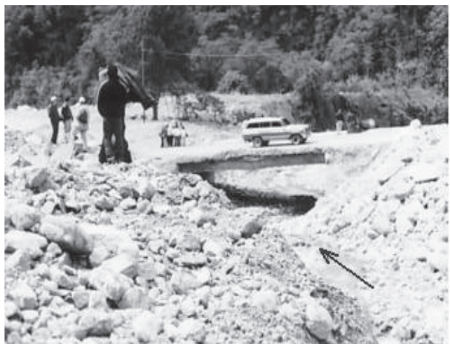
Figura 4. Quebrada La Sucia, Puente sobre la Trasandina.
