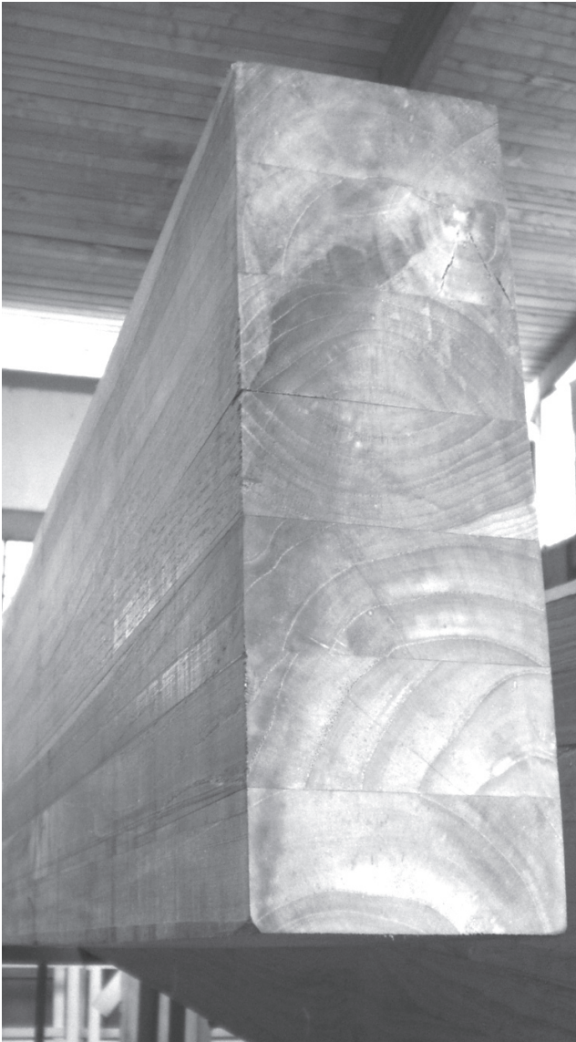
Figura 5. Vista de una sección transversal de una de las vigas laminadas encoladas de madera de teca, la cual deja apreciar su alto nivel estético. Foto: Mary Owen de Contreras.
