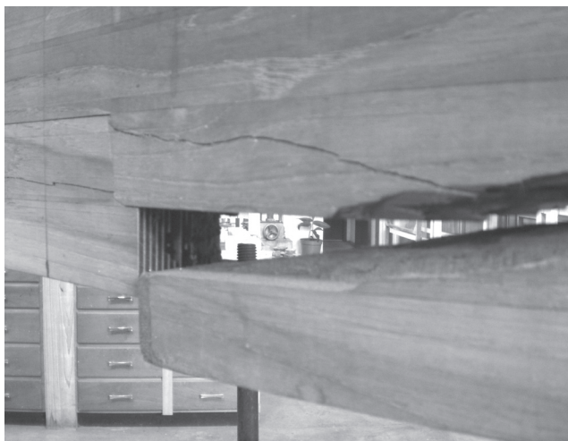
Figura 4. Vista de la falla seca ocasionada a partir de una unión de finger joint , ubicada en la zona de tracción de la viga al momento del ensayo de flexión. Se puede apreciar de igual forma una grieta por corte de la madera. Foto: Wilver Contreras.
