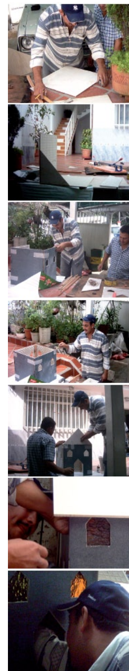
Secuencia del proceso de construcción de una capillita
