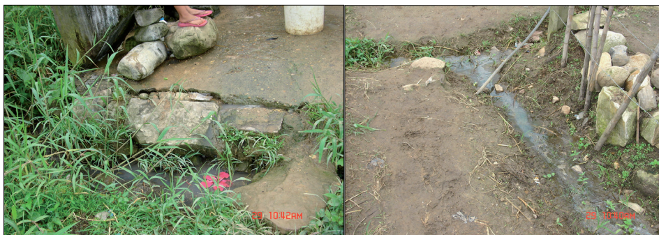
Figura 8. Desagüe de aguas negras, cerca de los lavaderos y vías de acceso.
