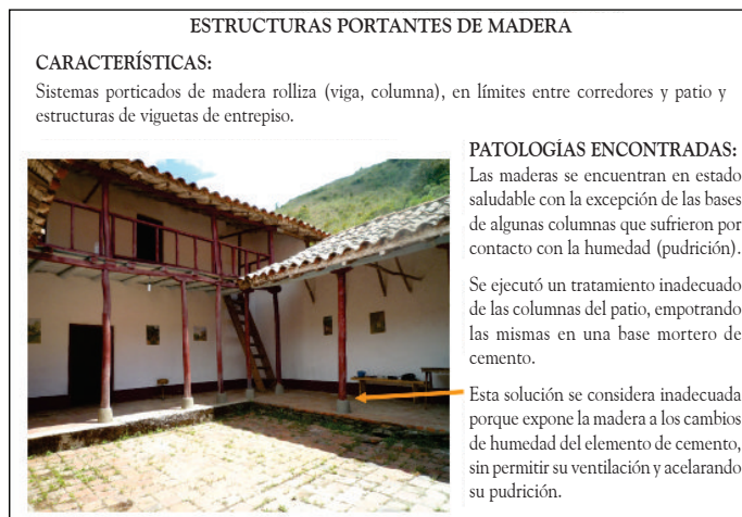
Fotografía Nº. 9. Diagnostico sobre las estructuras de madera. Anteproyecto Altamira de Mucumpís, El Morro, Municipio Libertador, Edo. Mérida (fuente propia).
