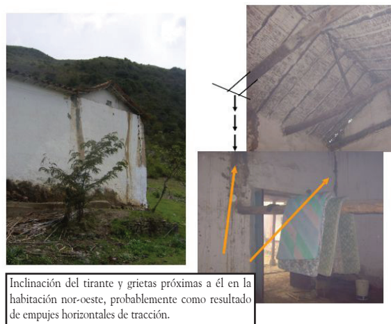
Fotografías Nº 5, 6 y 7. Diagnostico estado del inmueble. Estructura de techos. Ante-proyecto Altamira de Mucumpís. El Morro, Municipio Libertador, Edo. Mérida (Fuente propia).
