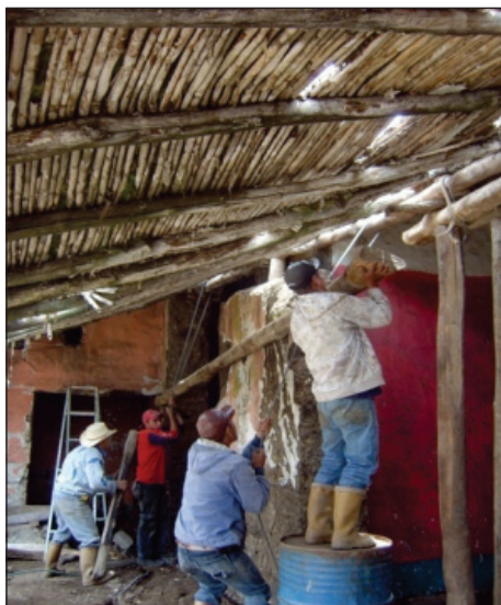
Fotografías N° 10 y 11. Arriba: tapialeros de Chacantá, Pueblos del Sur, Municipio Arzobispo Chacón. Abajo: Constructores de Mucuchíes, Municipio Rangel (fuente propia).
