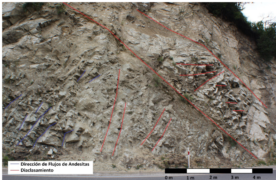
FIGURA 3. Afloramiento de rocas intrusivas tonalíticas (G t). En esta imagen, el afloramiento muestra un rumbo E-W, lo cual permite observar en primer plano, diaclasas estructuradas en sentido NNE-SSW, buzamiento 40°W. Adicional, es posible la observación de otras familias de diaclasas que se agrupan de manera casi paralela; entre las cuales sobresalen los sistemas que siguen la dirección de flujo (NNW – SSE), y otras diaclasas casi perpendiculares a la dirección de flujo (E – W)
