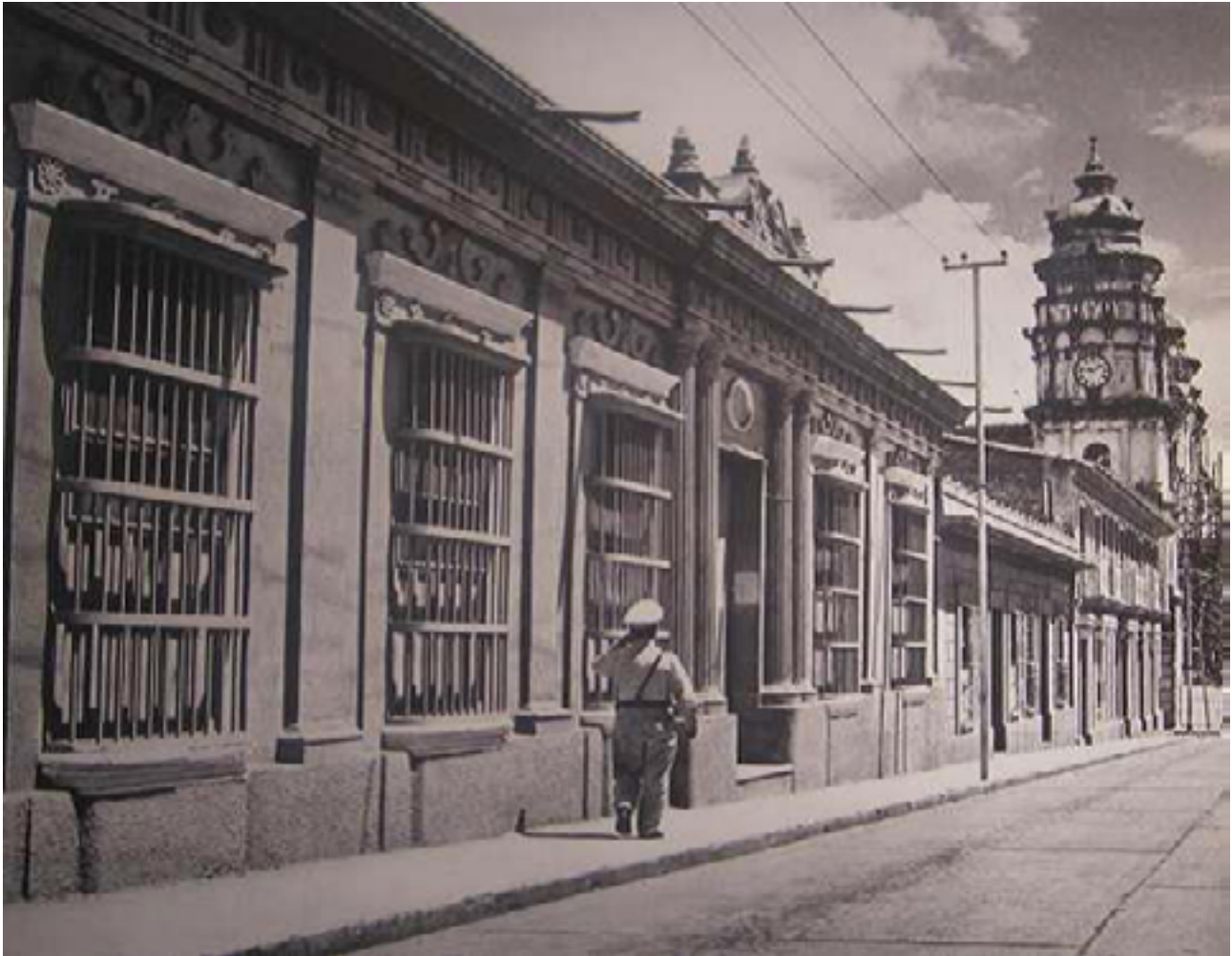
Avenida Bolívar entre calles 21 Lasso de la Vega y 22 Canónigo Uzcátegui. (1962). (Foto de Biblioteca Tulio Febres Cordero)
