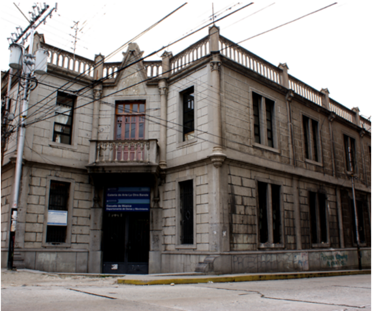
Edificio San José, ubicado en la avenida 5 Zerpa con calle 24 Rangel. (Foto de Leonardo Chacón Quintero. Año 2015)
