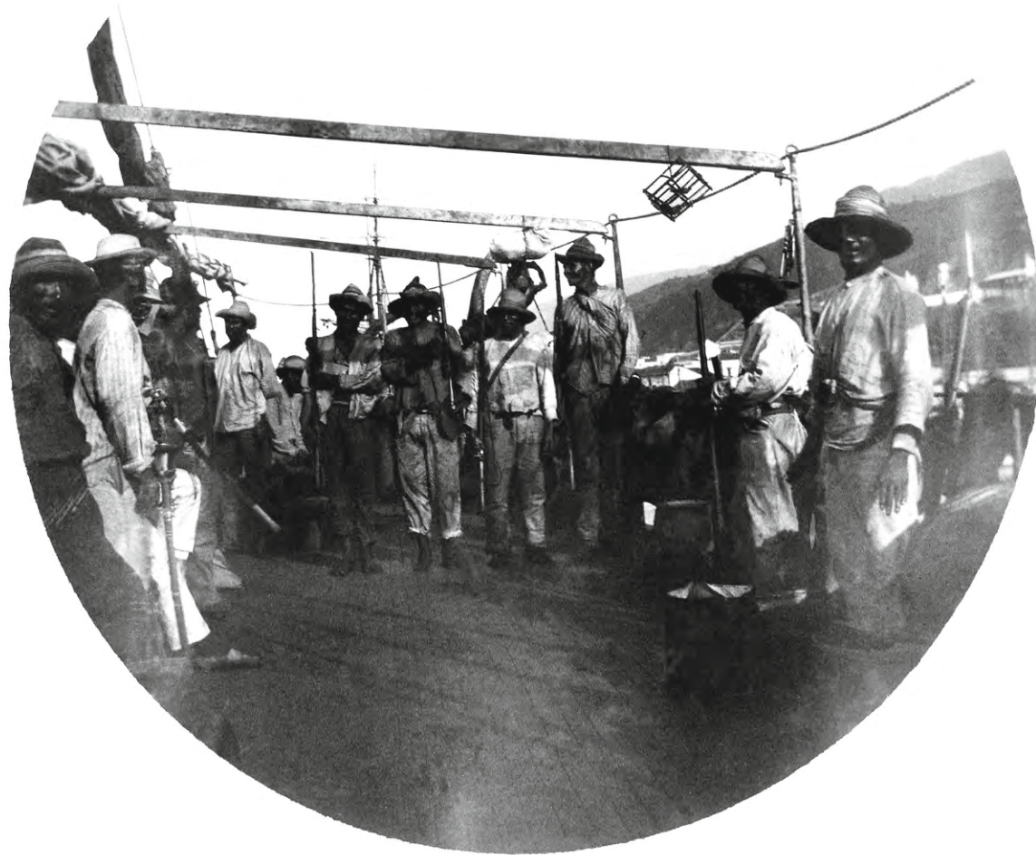
On the quarter-deck En la cubierta
