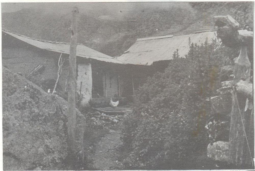
Segunda etapa. Casa únicamente de bahareque y techo enteramente de zinc.
