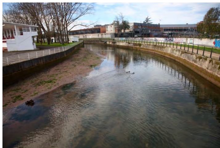
FIGURA 3. Encauzamiento del río Piles en Gijón. Fuente: Los autores (2021)
