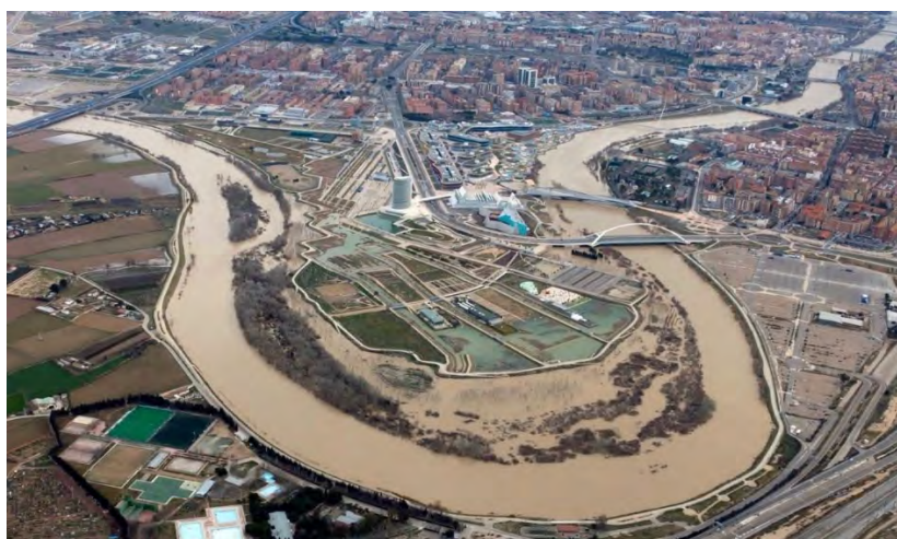
FIGURA 4. Parque del agua, Zaragoza. Fuente: Los autores (2013)
